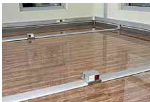
Dobbel el boks for gulvkanal system. Plass for 4 stk uttak.
