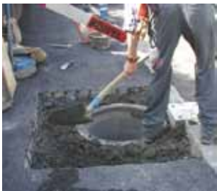
Plassering av betongrøret.
