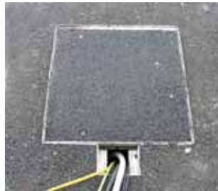
Fylling av dekseltrauet med asfalt, tilpasning til omgivelsene.
