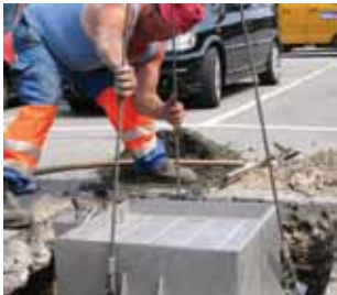
Tilpasning av enheten og nivel- lering til den riktige innbyggings- dybden.
