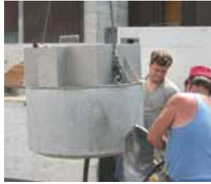
Utfresing av en åpning for tilførselskabelen i et standardbetongrør.
