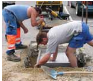
Innstøping av gulvboksen.
