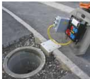
Påsatsringen som er levert fra GIFAS, er satt inn.
