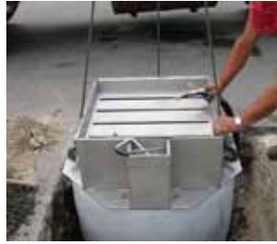
Nedsenking av hele enheten i den forberedte gropen.
