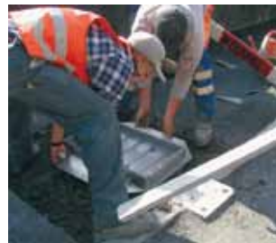
Påsatsdekket blir satt på.
