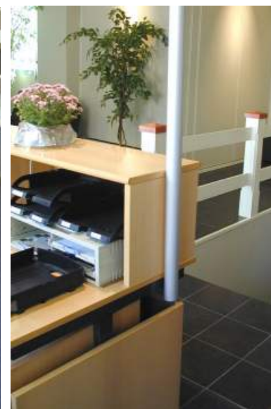
Festet til disk side. (Skruer direkte gjennom profil rygg)
